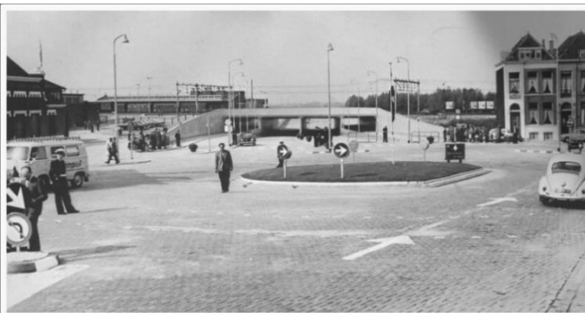
aanleg Irenetunnel ca 1960
